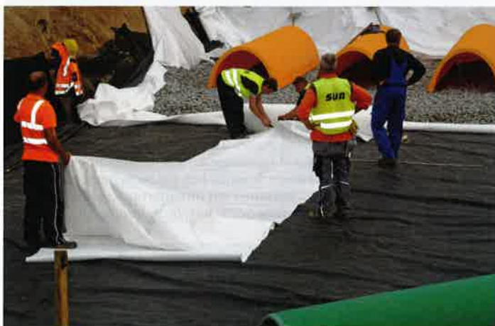
Unterirdisches Retentionssystem mit schwarzer PEHD-Folie, darauf Geotextil und Schottermaterial als Grundlage für die Birco-Rigolentunnel von StormTech.
