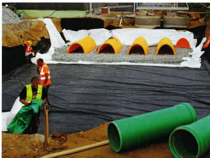
Bau der neuen Produktionshalle „Werk 2“ der Bitzer Kühlmaschinenbau GmbH in Schkeuditz bei Leipzig. Ein Drosseln des Regenabflusses auf 56 l/s ist erforderlich, um die Trennkanalisation nicht zu überlasten.
